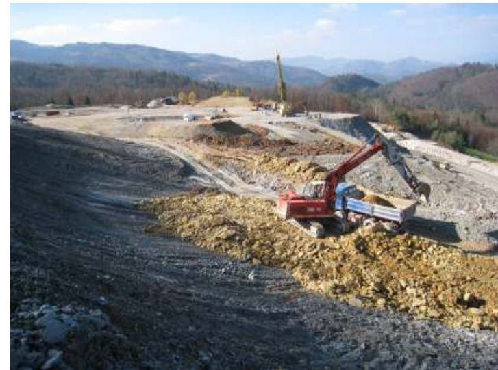
Boršt mill tailings site
